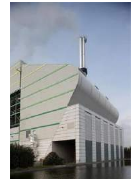
Chaudière Biowatts à Angers
